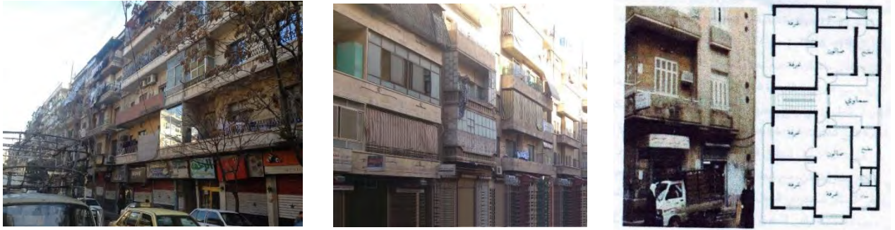
الشكل (2-10) بناء سكني، منطقة الحميدية/الشكل (2-11) بناء سكني جماعي متصل، بستان القصر/ الشكل (2-12) بناء سكني متصل، منطقة السليمانية (المصدر: التحولات التصميمية للعمارة السكنية في المدن السورية، ص34-عدسة الباحث)
