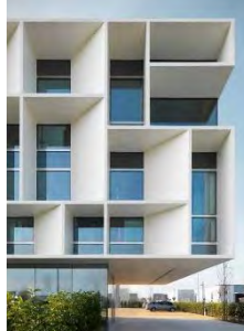
الشكل (1-102) تأثير معالجة الفتحات لتلائم مع المناخ لتقي من أشعة الشمس الحارة على الشكل المعماري
